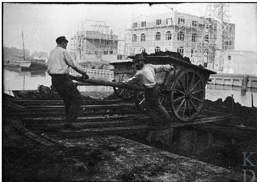
Porteurs de sable sur la quai de Jacob van Lennep, avec vue sur les bureaux et l'usine de la scierie Fijnhout en construction, 1900-1901. Collection RKD
